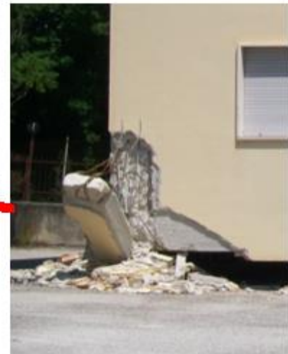
Edificio civile – terremoto de L'Aquila, magnitudo 6.3
